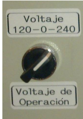
Figura 96. Selector Sistema 120V o 240V
