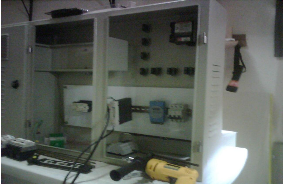
Figura 84. Instalación de equipos 3
