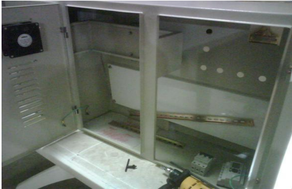
Figura 82. Instalación de equipos 1
