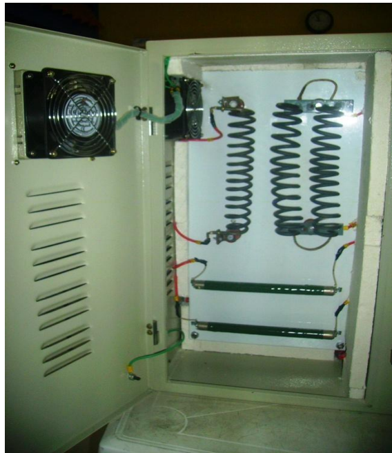
Figura 87. Instalación de equipos 6 Fuente. Autores.
