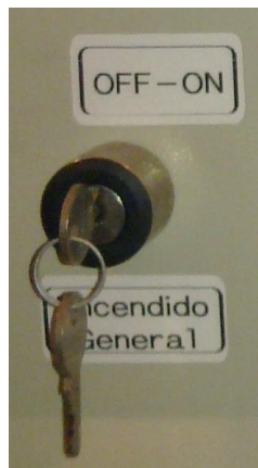
Figura 95. Selector con llave de encendido.
