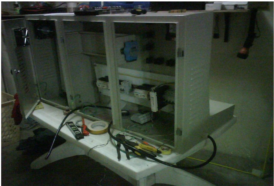
Figura 85. Instalación de equipos 4
