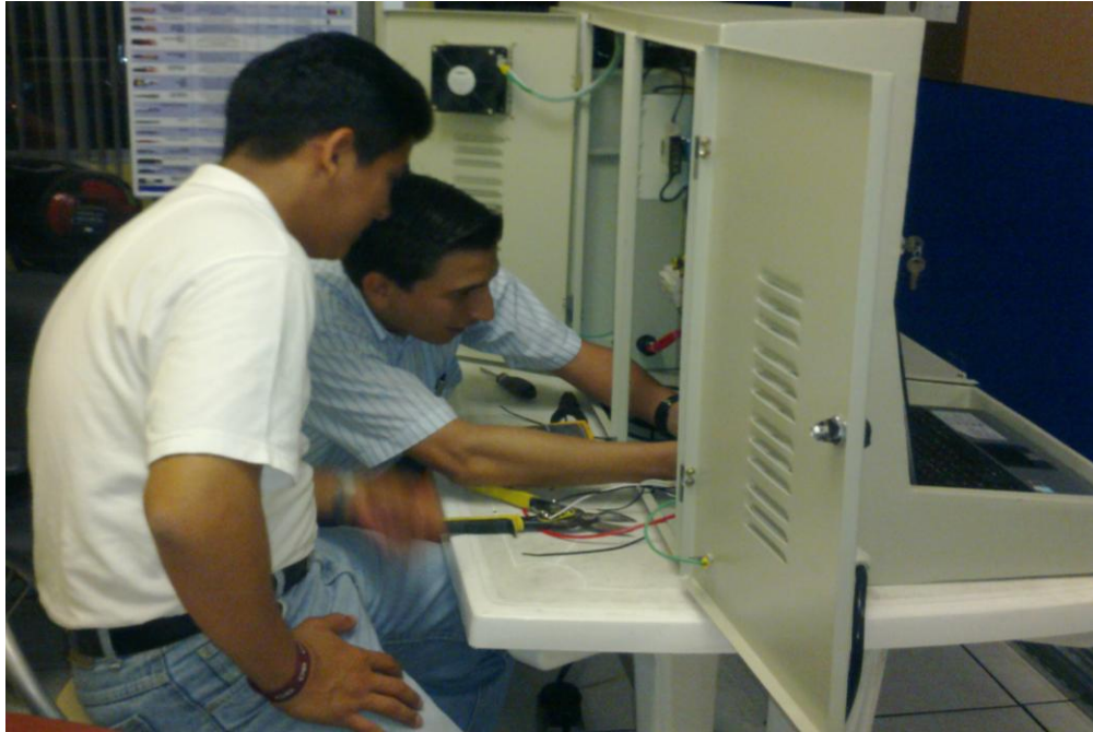
Figura 90 Instalación de equipos 9
