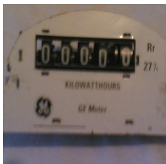
Figura 24 El registró o esfera ciclo métrica.
