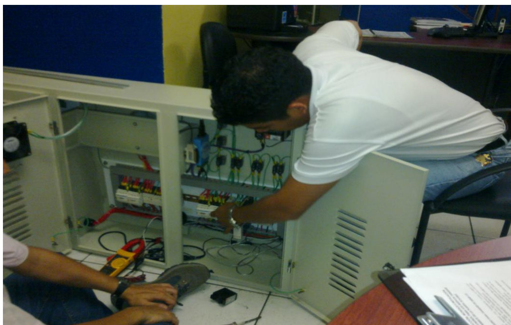
Figura 89. Instalación de equipos 8
