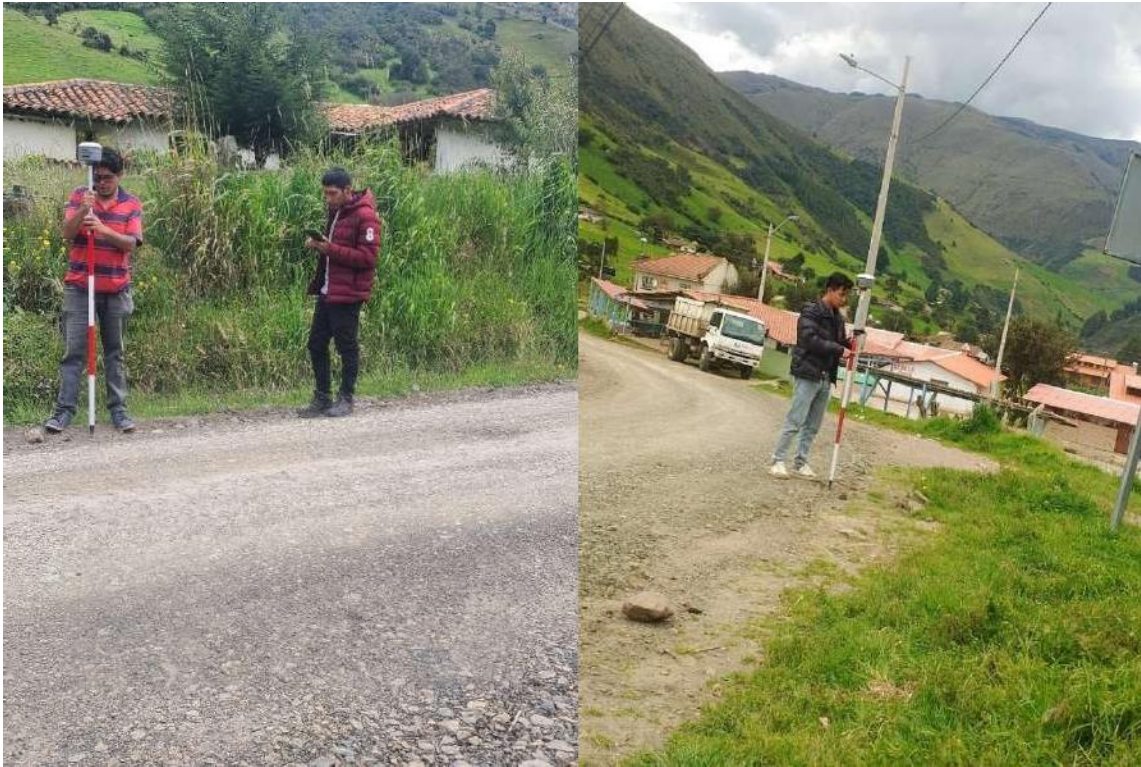
Levantamiento Topográfico con Equipo RTK
