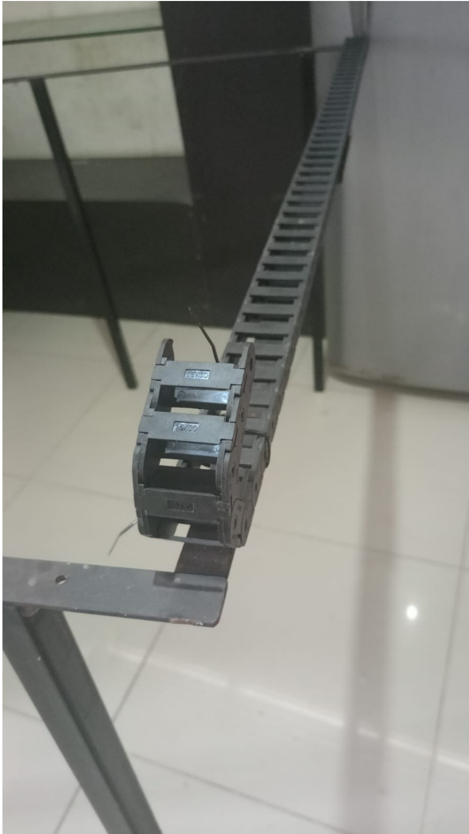
Figura 40. Cableado ingresado en el Drag Chain
