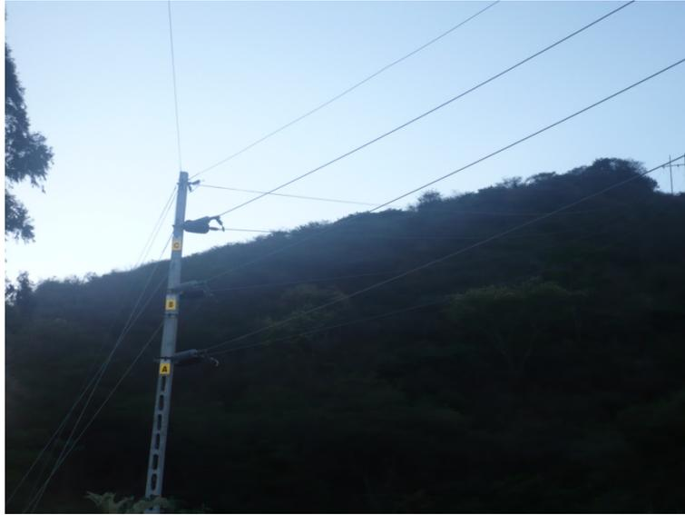
Los transformadores usados en la red de distribución, son alimentados con la línea de 13.8 KV a lo largo de toda la red. La potencia utilizada en la mayoría de los casos es de 10 KVA cubriendo una demanda de hasta 10 abonados en el área rural, aunque en algunos sectores existen transformadores de 5 y 25 KVA. En el caso particular de las hosterías del sector, la mayoría cuenta con un transformador propio.
