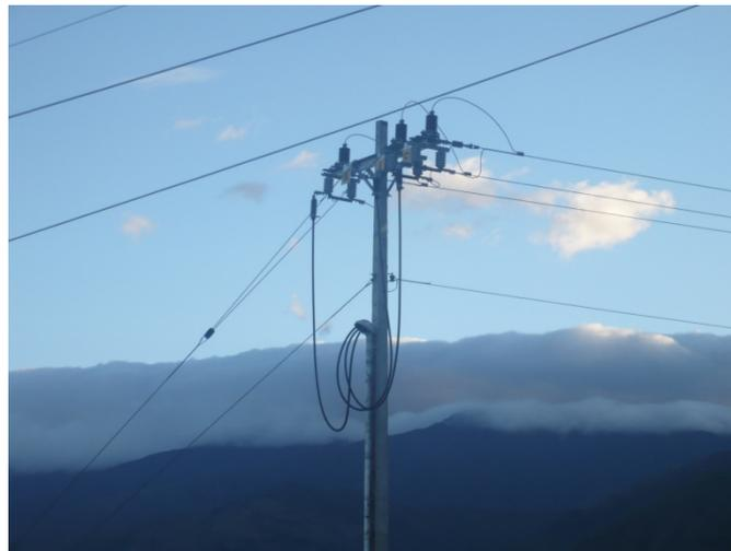
La acometida según las normas de diseño que rigen en la EERSSA no debe sobrepasar los 100 m medidos desde el transformador hasta el medidor del usuario final.
