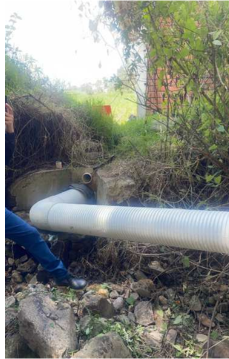
(b) Vista de la tubería instalada.
