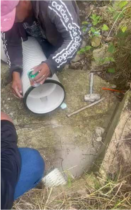
(a) Proceso de instalación de la tubería.
