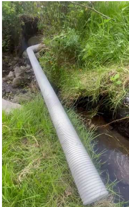
(c) Ilustración de la tubería extendiéndose a lo largo del terreno.
