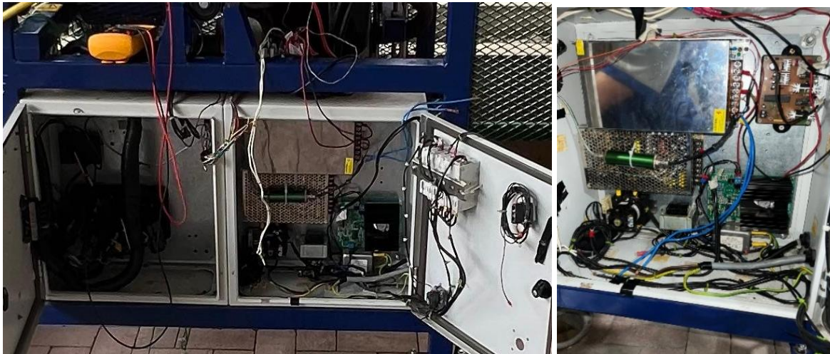
Fig. 18. Reacondicionamiento del gabinete y conexiones eléctricas.
