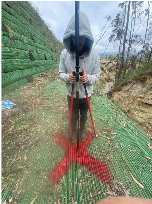
Fotografía 10 Monitoreo de punto ubicado en el muro de contención Fuente: (Bustamante Javier, Aguilar Freddy, 2025)
