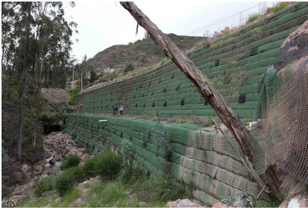
Fotografía 7 Muro de contención al costado de la vía principal Fuente: (Bustamante Javier, Aguilar Freddy, 2025)
