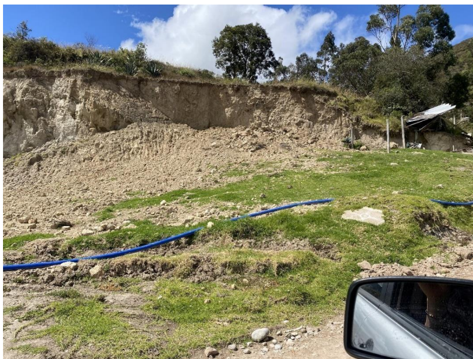
Fotografía 6 Seccionamiento de montañas con alto contenido de arcilla en las partes altas del sector Fuente: (Bustamante Javier, Aguilar Freddy, 2025)
