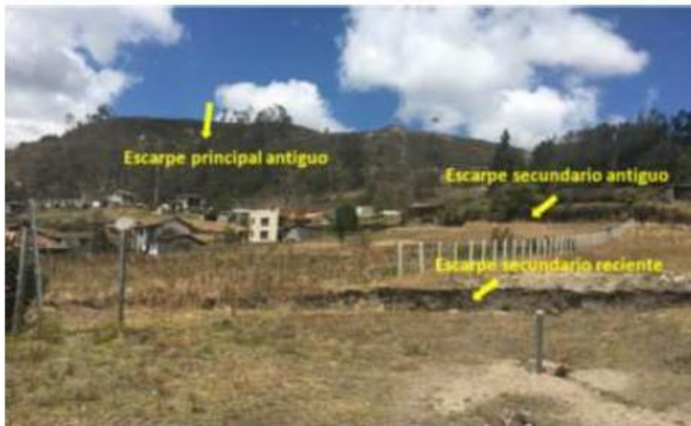
Imagen 9 Escarpe principal y secundarios antiguos y recientes Fuente: (Geoproject, 2021)
