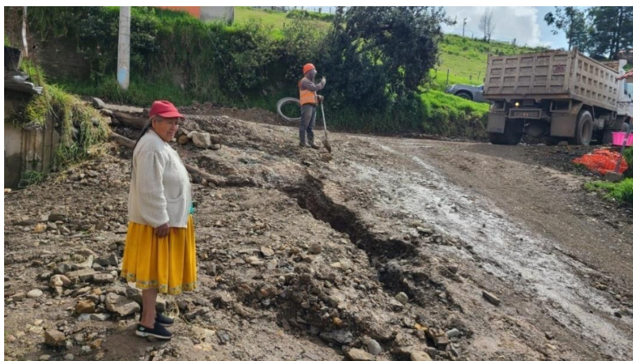
Fotografía 2 Mantenimiento de vías transversales ladere abajo, cerca la cabecera cantonal Fuente: (Bustamante Javier, Aguilar Freddy, 2025)
