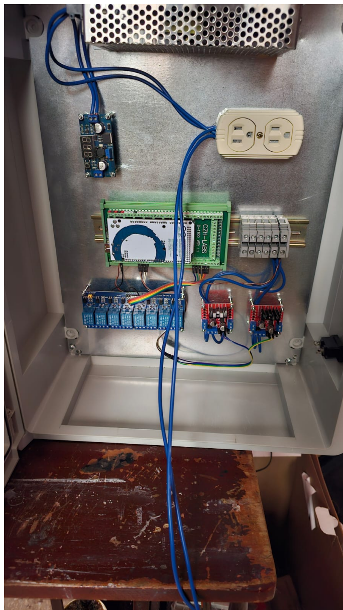
Figura 26. Construcción de tablero. Fuente: Los Autores
