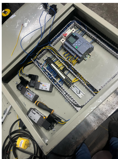
Figura 42. Proceso de armado 2.
