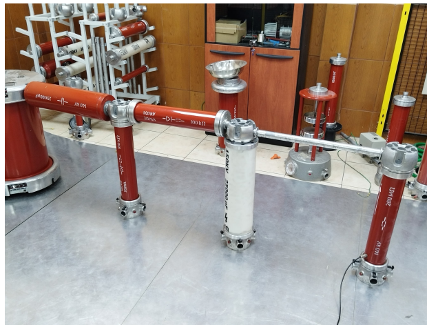
Figura 56: Configuración del circuito rectificador tras la reposición de condensadores
