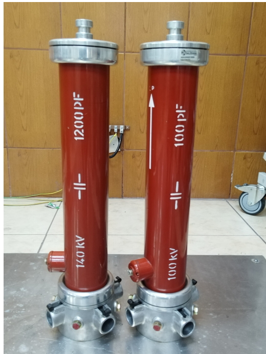
Figura 15: Capacitores HV9141 y HV9120 del laboratorio de alta tensión
