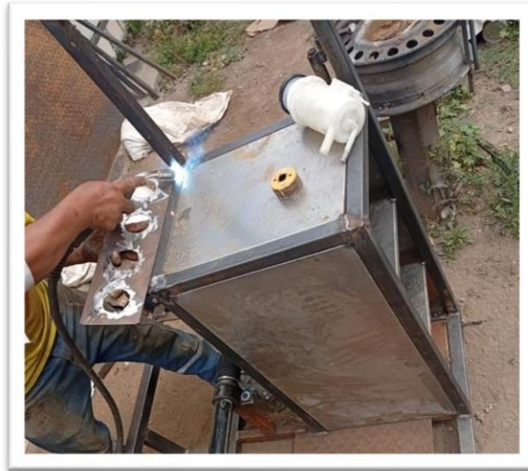
Figura 4.26: Soldadura de base de medidores y láminas de relleno
