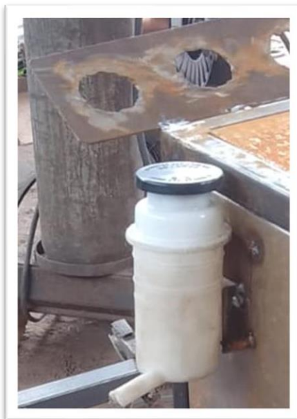
Figura 4.27: Soldadura de base de depósito de líquido hidráulico
