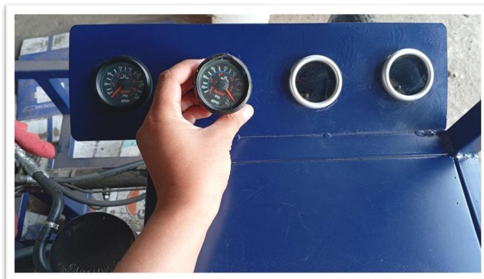
Figura 4.37: Instalación de medidores de presión y temperatura
