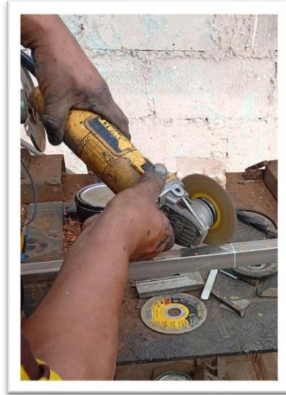
Figura 4.18: Corte de tubos para la estructura
