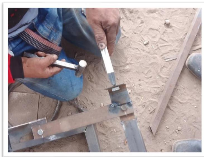
Figura 4.21: Soldadura de platinas
