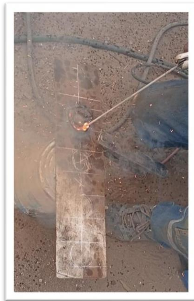
Figura 4.25: Soldadura soporte de medidores de presión y temperatura
