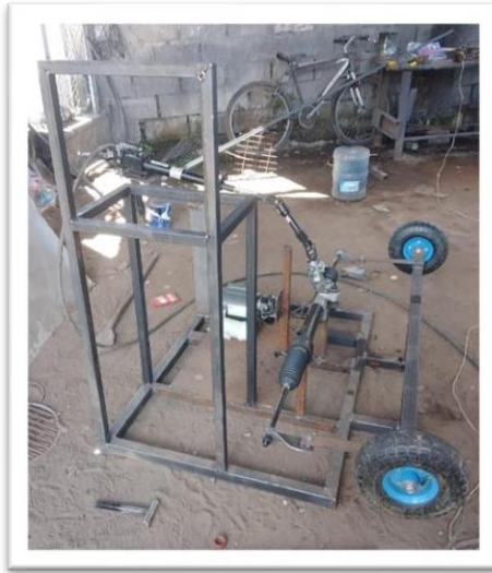
Figura 4.24: Montaje de elementos para comprobación de medidas y estabilidad
