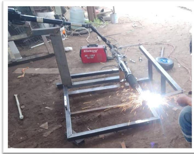
Figura 4.20: Soldadura de apoyos de neumáticos, cremallera y columna de dirección
