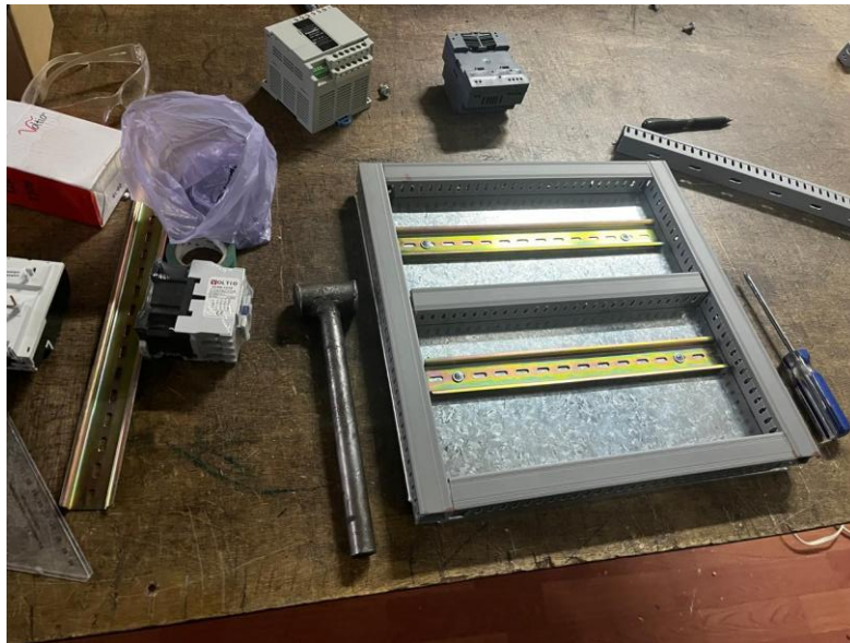
Figura 41. Ensamble de riel DIN y canaleta
