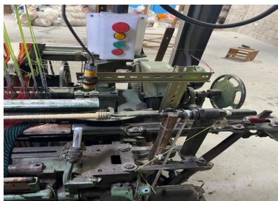
Figura 50. Instalación del sistema de bobinado semiautomático asistido
