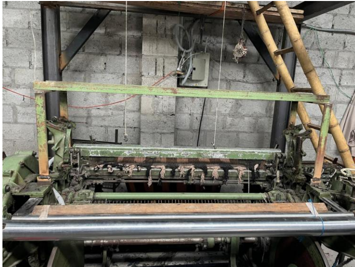
Figura 37. Desmontaje del telar de lanzadera
