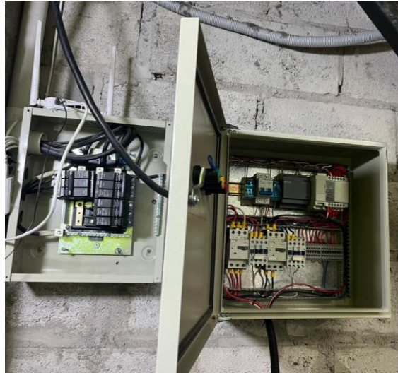
Figura 43. Instalación de la Caja de control y conexión de partes electrónicas
