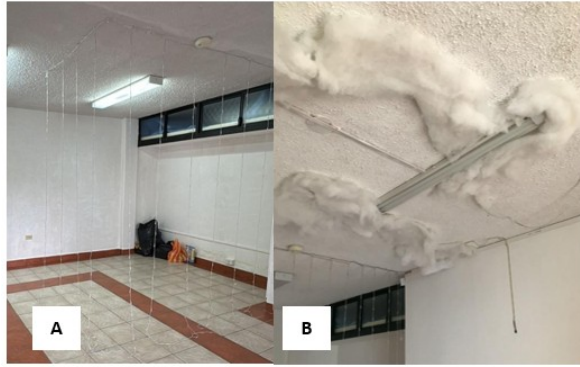
Figura 31: Instalación de las luces LED de cascada y tiras LEDs.
