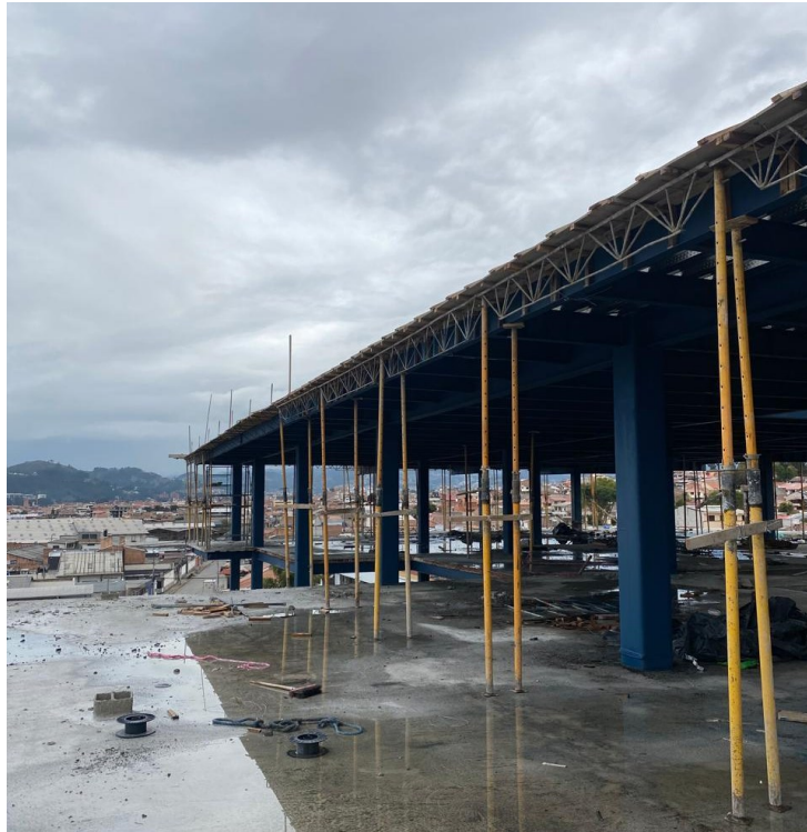
Anexo 1. Vista general del edificio en proceso constructivo
