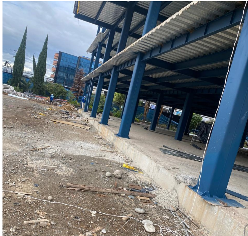
Anexo 2. Vista general del edificio en proceso constructivo
