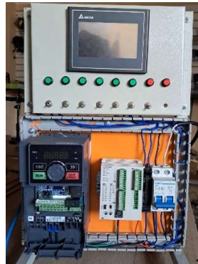
Figura 30. Cableado de equipos
