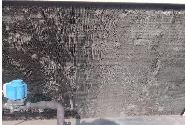
Anexo 9. Imagen de evaporador (cámara #1)
