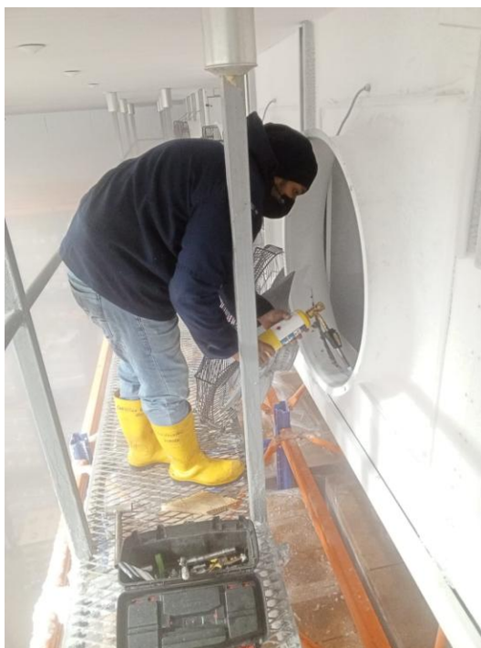
Figura 6. Equipos evaporadores en cámara de enfriamiento
