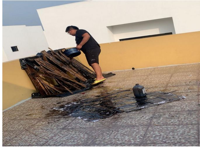
Figura 14: Proceso de impermeabilización [40].
