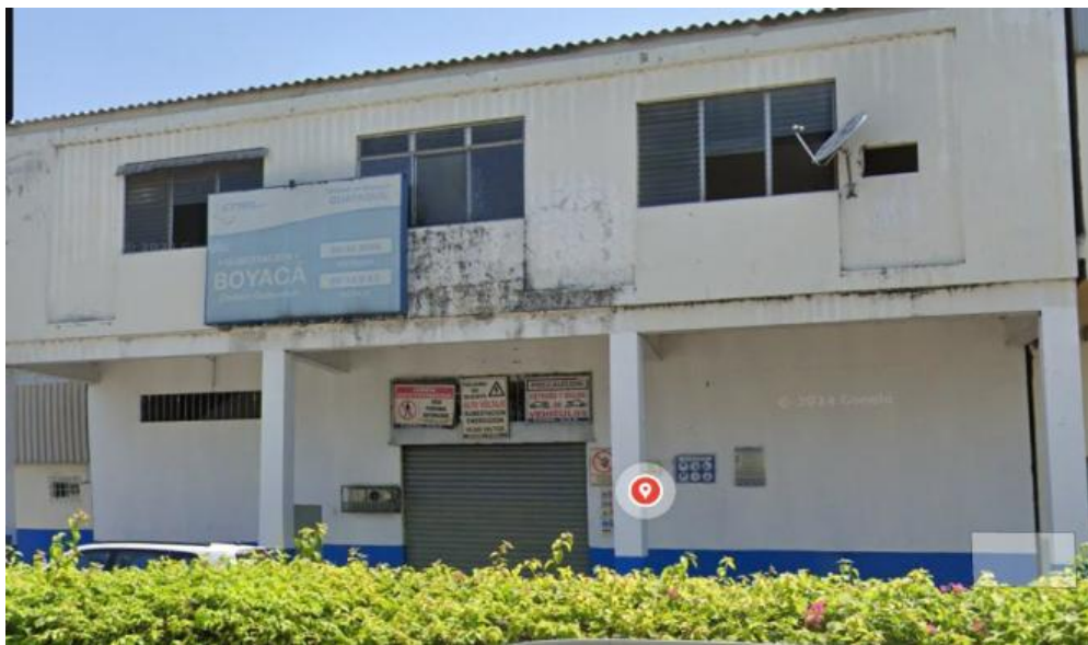
Figura 22. Subestación Boyacá en su localidad Fuente: Tomado de [73]
