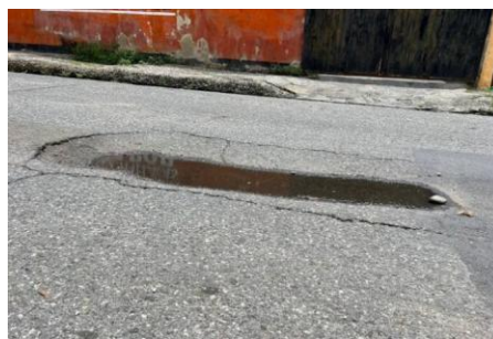
Figura 12. Hundimiento
