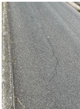
Figura 3. Fisura longitudinal.
