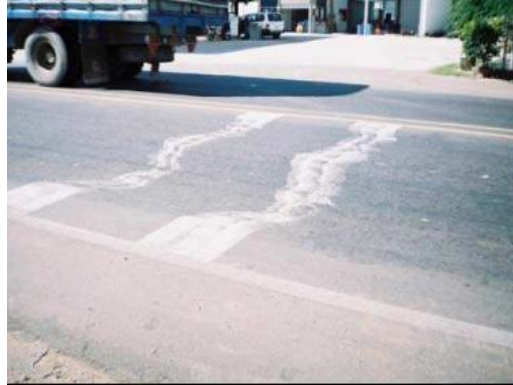
Figura 13. Ahuellamiento
