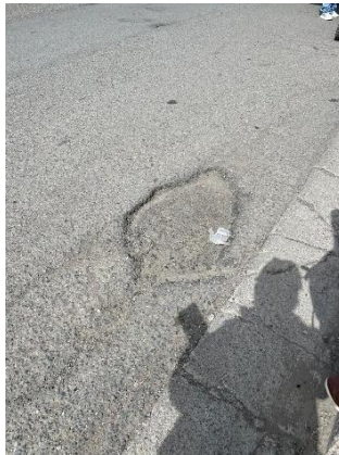
Figura 14. Descascaramiento
