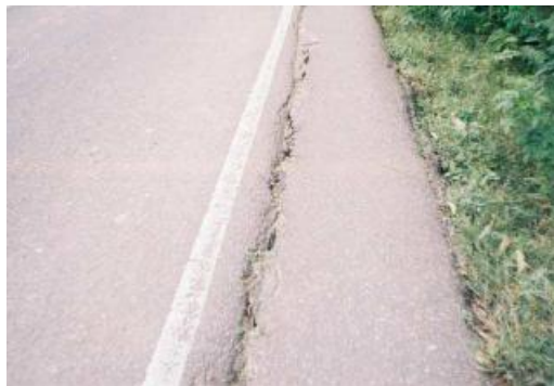
Figura 23. Separación de la berma
