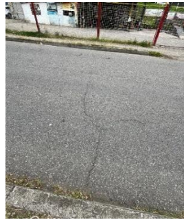
Figura 4. Fisura transversal.
