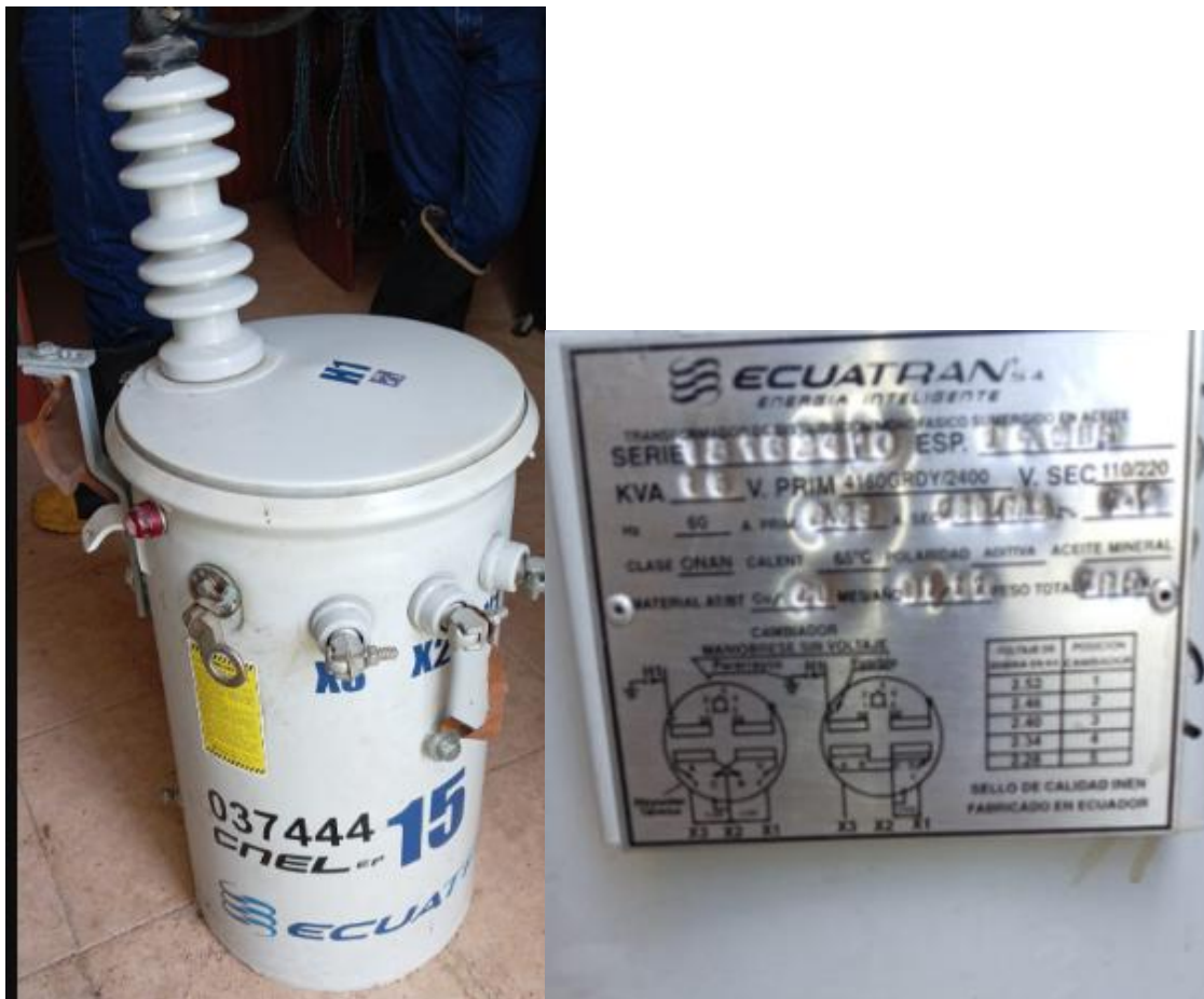
Ilustración 69. Transformador 15kVA
