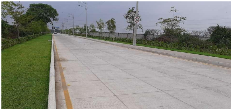
Ilustración 5. Pavimento rígido.
