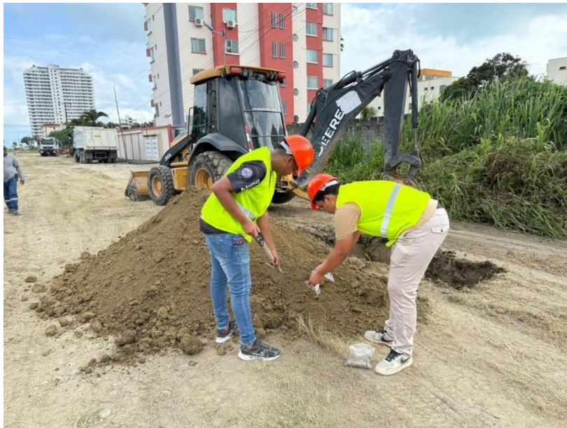
Ilustración 22. Extracción de muestra de suelo para ensayos.
