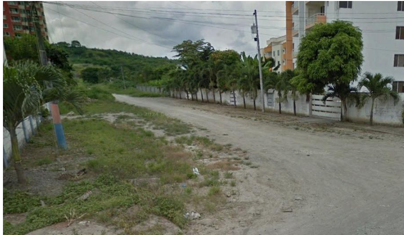
Ilustración 16. Fotografía del estado actual de la Avenida B.
