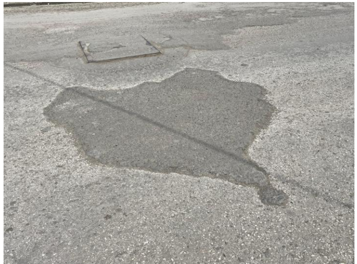
Figura 67. Parcheo en la unidad de muestreo 4 (Abscisa: 0+360 / 0+400)
