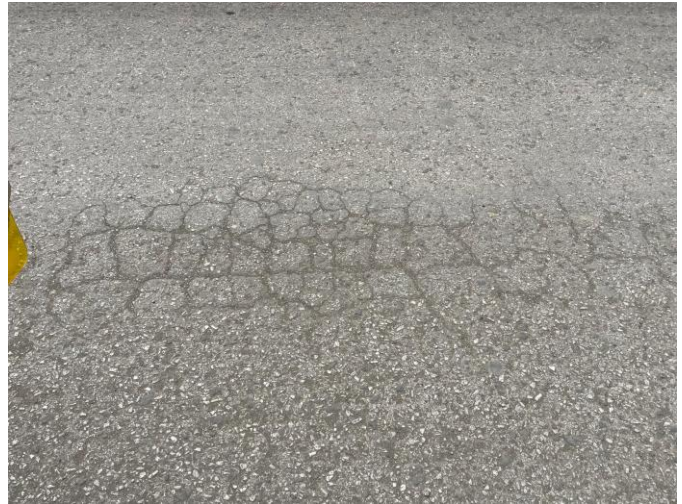
Figura 65. Piel de cocodrilo en la unidad de muestreo 3 (Abscisa: 0+240 / 0+280)
