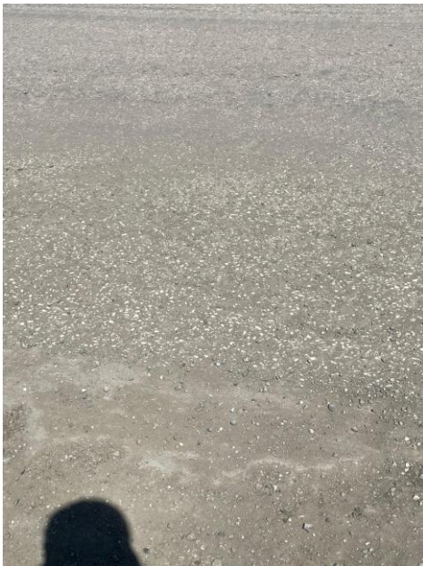
Figura 66. Pulimento de agregados en la unidad de muestreo 3 (Abscisa: 0+240 / 0+280)
