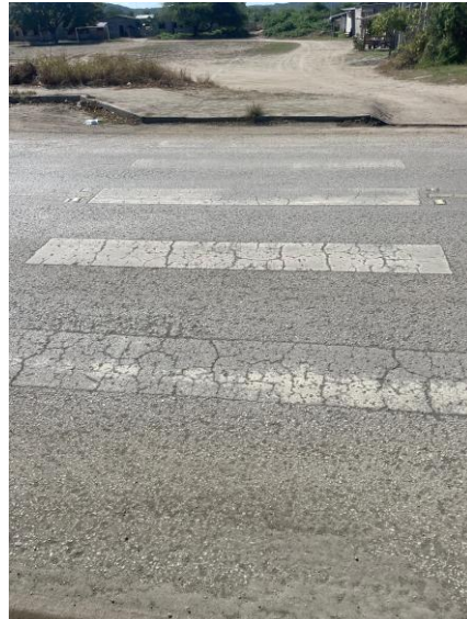
Figura 69. Piel de cocodrilo en la unidad de muestreo 7 (Abscisa: 0+720 / 0+760)
