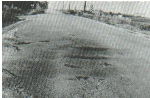
Figura 17: Falla de desplazamiento
