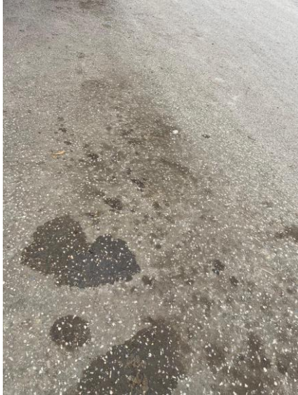
Figura 68. Pulimento de agregados en la unidad de muestreo 4 (Abscisa: 0+360 / 0+400)
