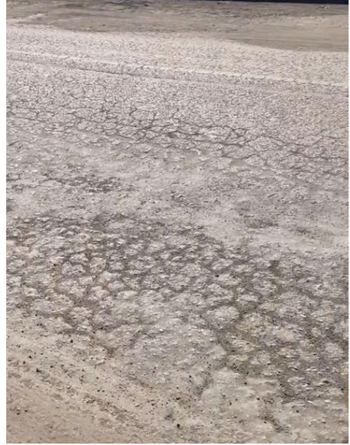
Figura 73. Piel de cocodrilo de severidad alta en la unidad de muestreo 11 (Abscisa: 1+200 / 1+240)
