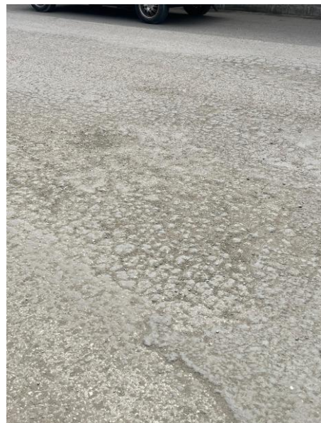
Figura 63. Piel de cocodrilo en la unidad de muestreo 2 (Abscisa: 0+120 / 0+160)
