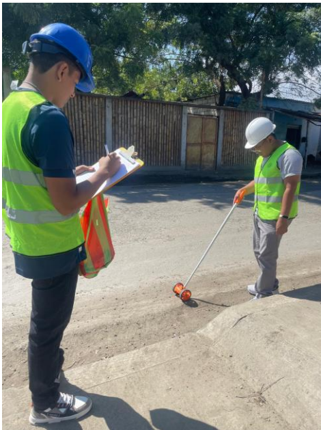
Figura 74. Medición de los tramos mediante odómetro
