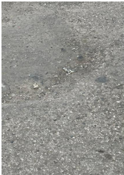
Figura 70. Abultamiento y hundimiento en la unidad de muestreo 8 (Abscisa: 0+840 / 0+880)
