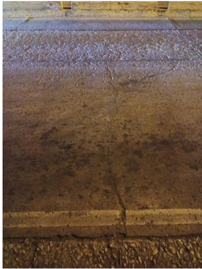
Ilustración 6 12(UM)Tramo 1 carril derecho
