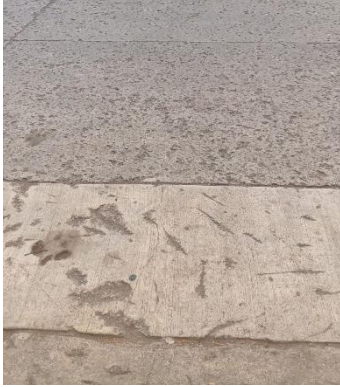
Ilustración 20 4(UM) Tramo 1 carril derecho
