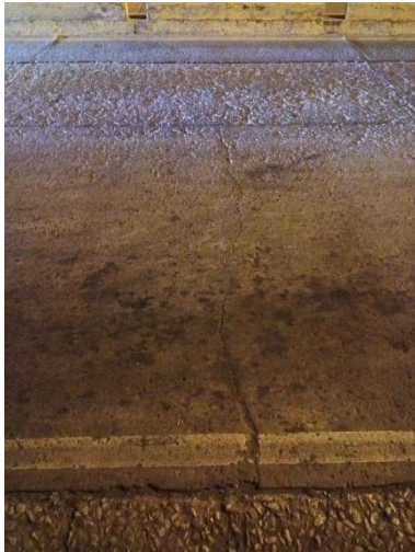
Ilustración 14 5(UM)Tramo 2(carril derecho)
