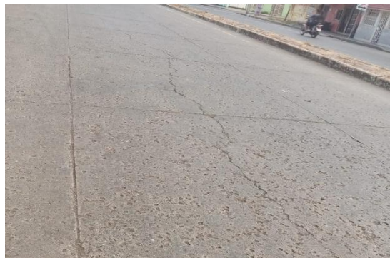
Ilustración 46 grieta lineal (15.63)
