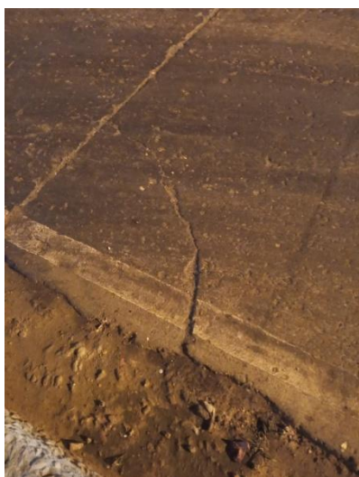
Ilustración 4 3(UM)Tramo 1 carril derecho
