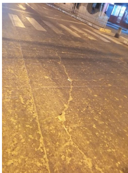
Ilustración 54 losa dividida (1.76)
