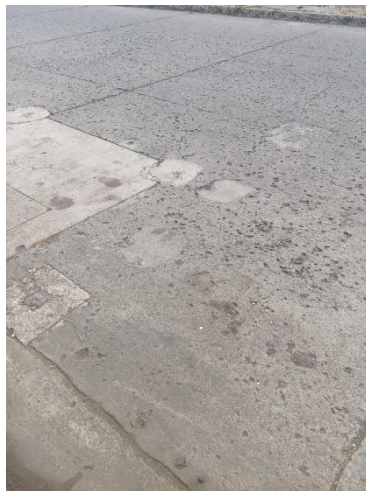
Ilustración 21 2(UM) Tramo 2 carril derecho
