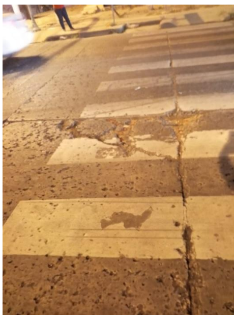
Ilustración 57 punzonamiento (0.12)
