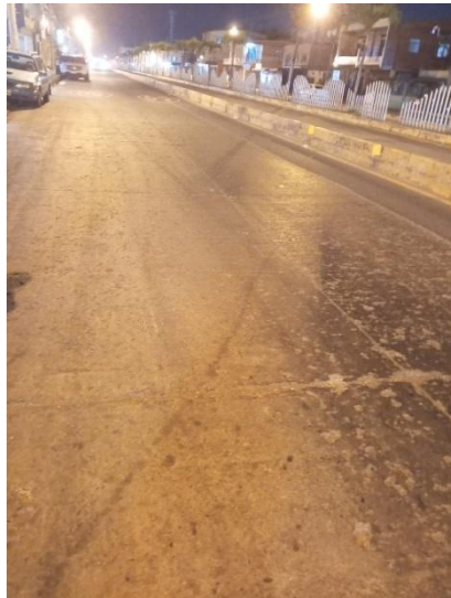
Ilustración 53 pulimiento de agregados (2.17)
