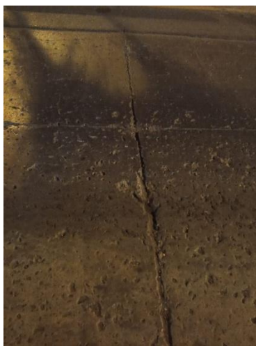
Ilustración 10 5 (UM)Tramo 1 carril derecho
