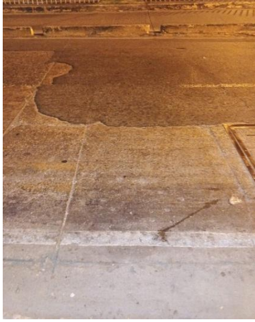
Ilustración 16 8 (UM) Tramo 1(carril derecho)
