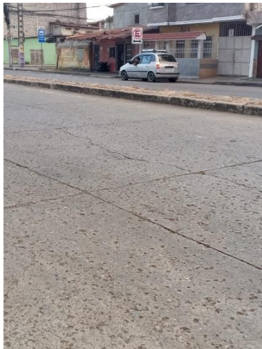
Ilustración 9 2(UM)Tramo 2 carril derecho
