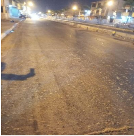
Ilustración 22 12 (UM) Tramo 1(carril derecho)
