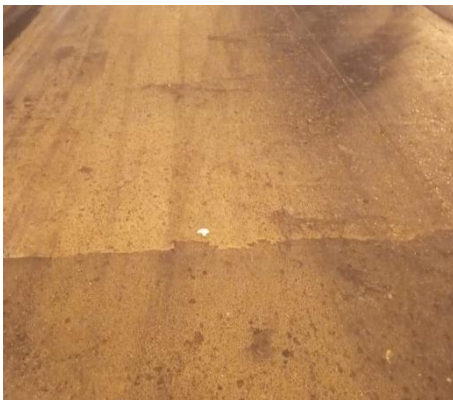
Ilustración 24 5(UM) Tramo 2(carril derecho)
