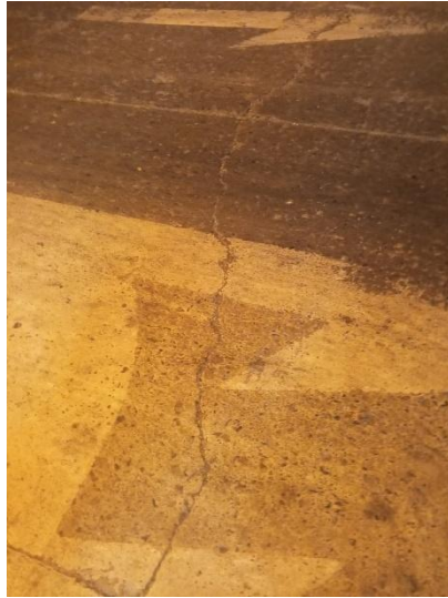
Ilustración 12 5(UM)Tramo 1(carril derecho)
