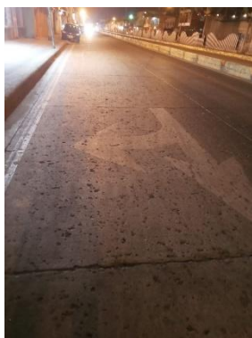
Ilustración 26 Falla popouts
