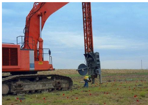
Ilustración 13: Drenes Sísmicos (Wick Drains)
