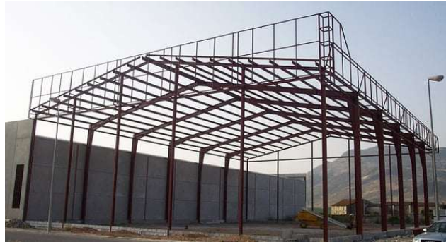
Figura 5. Arriostramiento de nave industrial.
