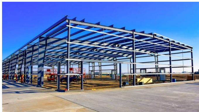
Figura 2. Estructura principal de una nave industrial.
