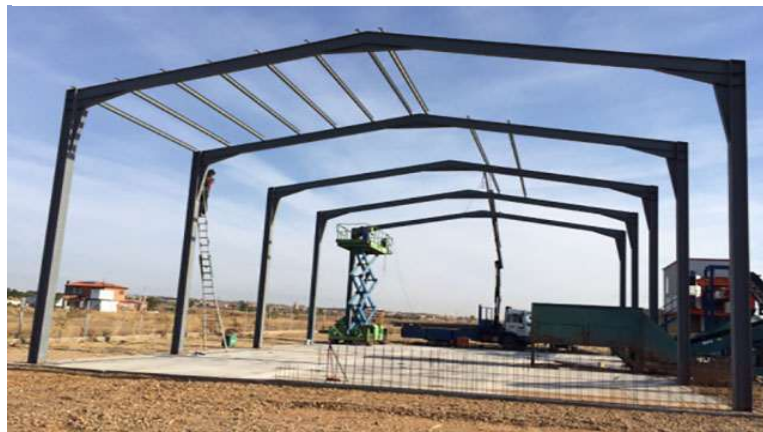
Figura 10. Edificación industrial conformada predominantemente por elementos estructurales metálicos (vigas, columnas, cerchas).
