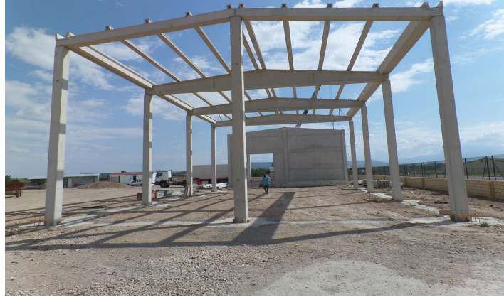
Figura 9. Nave industrial con estructura completamente en hormigón armado.
