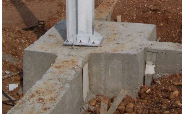
Figura 8. Cimentación de nave industrial.
