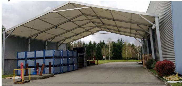
Figura 6. Cubierta metálica de nave industrial.
