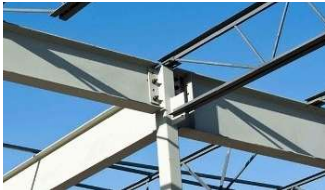
Figura 7. Conexión estructural de nave industrial.
