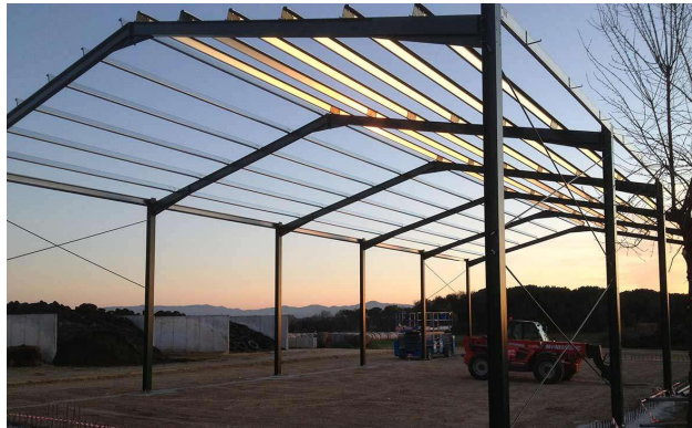
Figura 4. Nave industrial en etapa de construcción.
