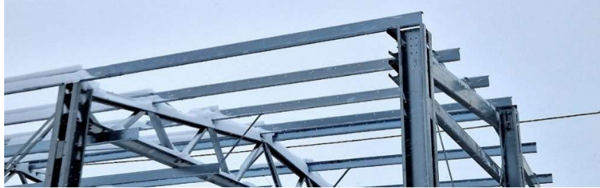
Figura 3. Correas en nave industrial metálica.
