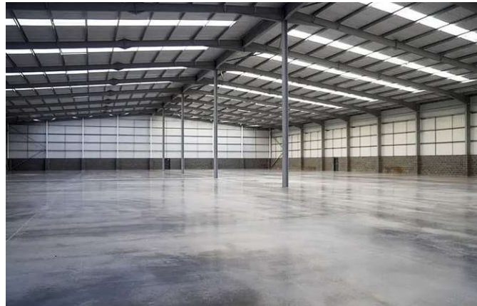
Figura 11. Nave industrial que combina elementos estructurales de acero (como cerchas y vigas) con elementos de hormigón armado (como columnas y cimentación).
