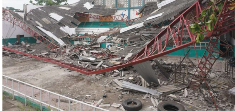
Figura 17. Estructura colapsada por el sismo del 25 de abril de 2025 en Esmeraldas.
