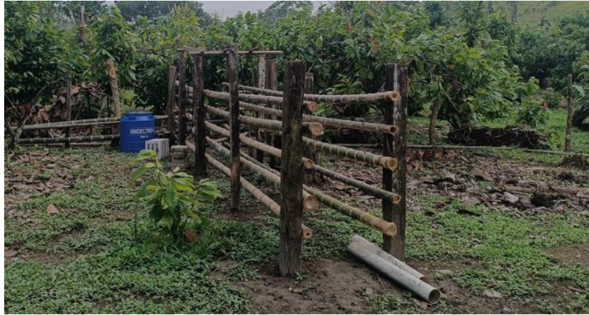
Figura 39. Construcción pasillo del corral.
