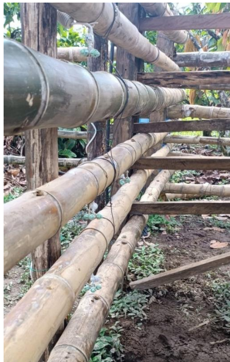
Figura 40. Construcción de tuberías y ubicación de aspersor.
