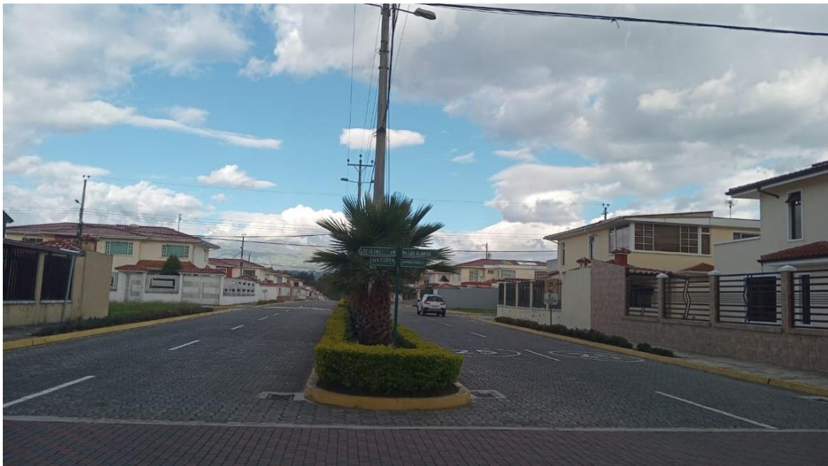
Tramo de vía de la comunidad “San Pedro de Taboada”
