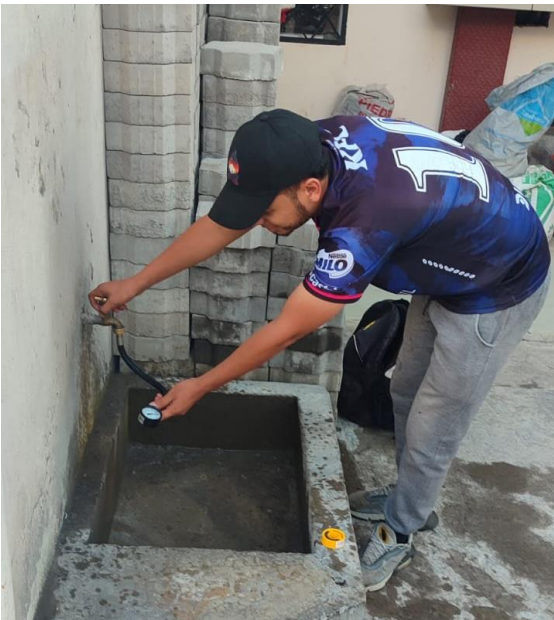
Anexo 3: Instalación de manómetro.
