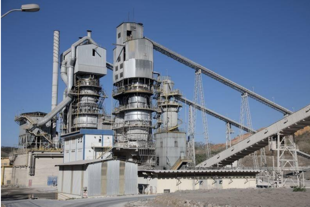
Figura 7 Horno Vertical de cal
