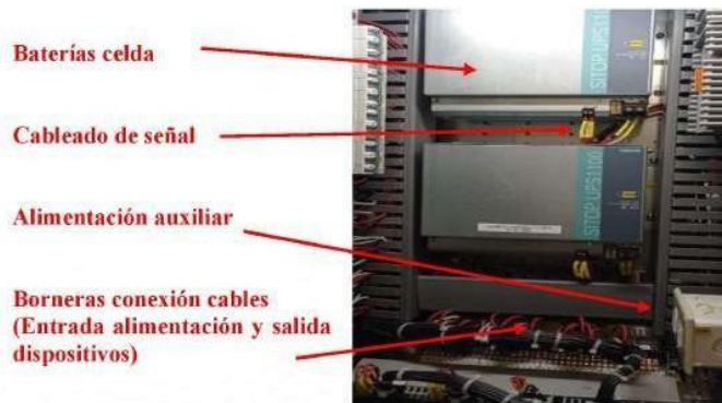
Figura 11 Baterías WEIDMÜLLER de la celda Siemens 8DJH (Fuente autor)
