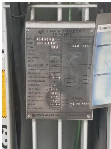
**Figura 24.** Placa característica Transformador trifásico
