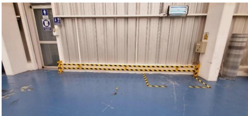
Figura 11. Reparación de bordillos e implementación de estructura metálica.
