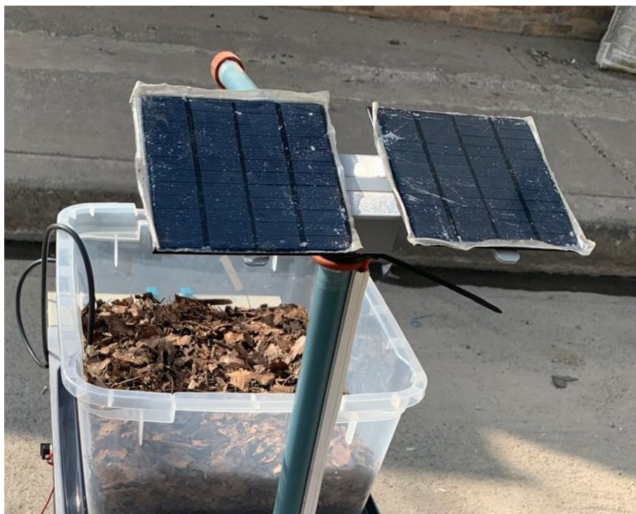
Figura 36. Fijación y Conexión del Panel Solar. Fuente: Los Autores.
