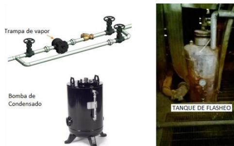
Figura 14. Equipos para la recuperación de condensado.[30]
