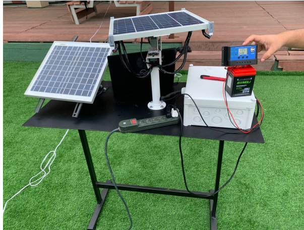
Figura 34: Montaje del seguidor solar. Fuente: Autores.
