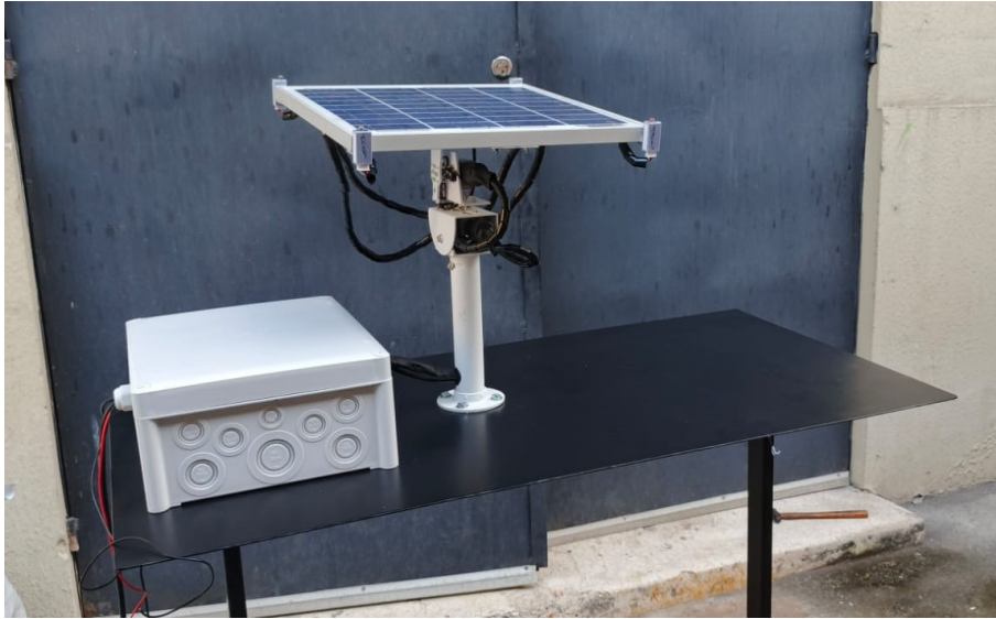
Figura 62: Instalación del seguidor solar sobre la mesa. Fuente: Autores.
