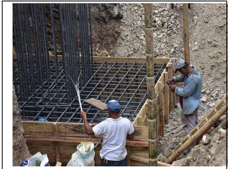
Ilustración 25. Diseño y ejecución de cimentación profunda
