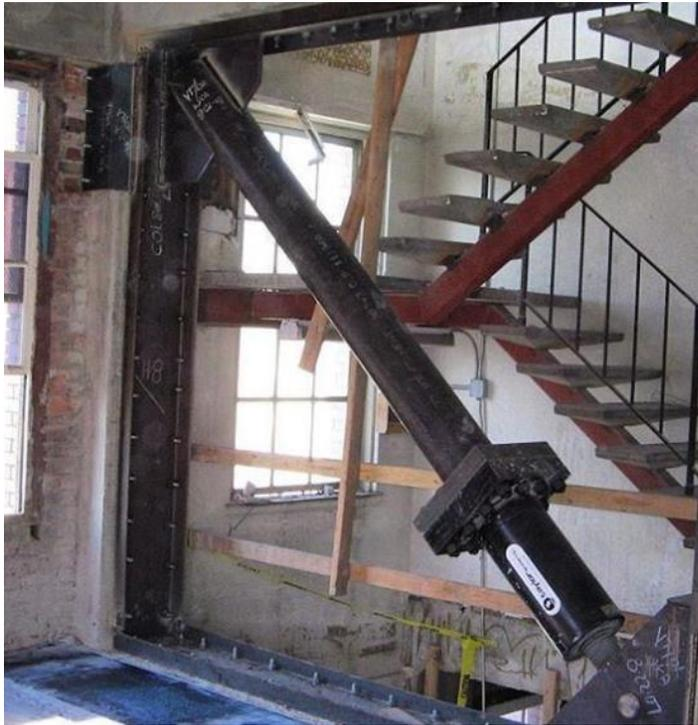
*Nota:* Dispositivo de amortiguación sísmica [Disipador BRB]. (s.f.). [Fotografía].
