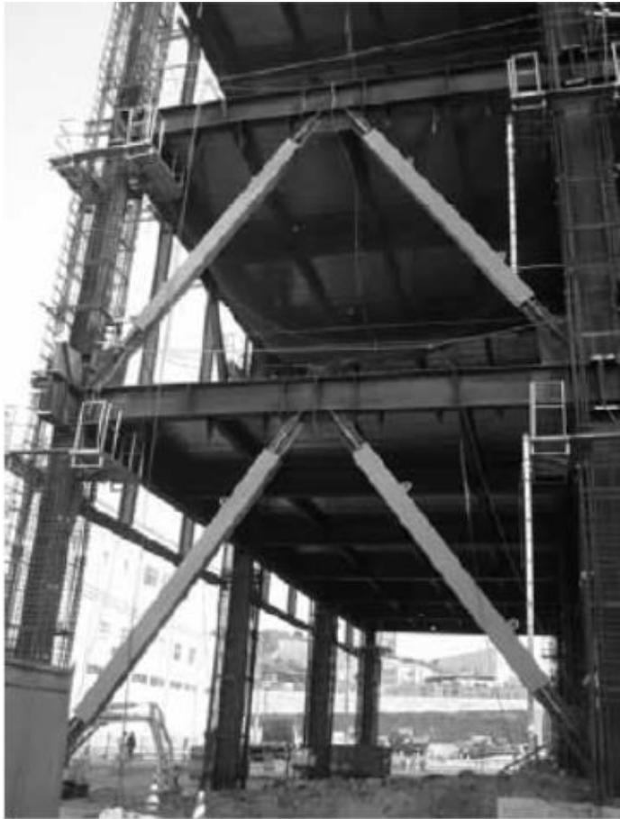
La Figura 10 se observa un ejemplo de un edificio de acero con un sistema de arriostramiento compuesto por riostras de pandeo restringido. Este tipo de estructura, común en zonas sísmicas, evidencia la importancia de controlar las deformaciones laterales para certificar la seguridad de los habitantes. Las riostras, dispuestas en un patrón en "X", contribuyen a mejorar la rigidez lateral del edificio y a reducir las fuerzas internas generadas por cargas laterales.
