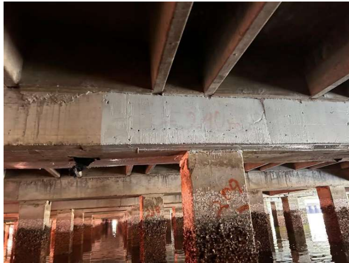
Imagen 71: Resanes con mortero
