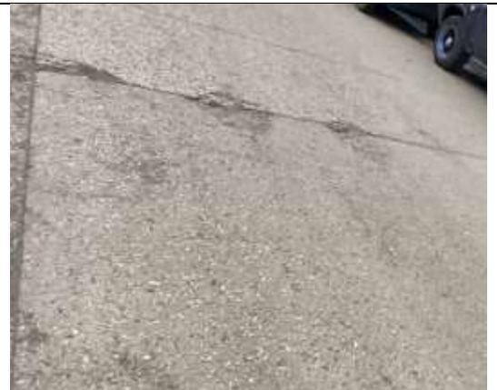
Figura 18: Descascaramiento de Junta
