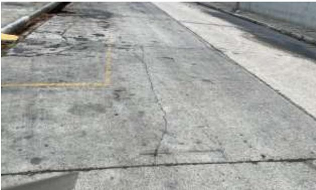
Ilustración 19 : Pulimiento de agregados – m 0+020 – 0+030
