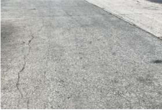
Ilustración 13: Pulimiento de agregados – m 0+000 – 0+010
