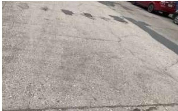
Ilustración 62: Descascaramiento de junta m 0+280 – 0+320
