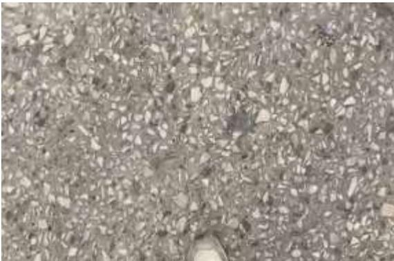
Ilustración 61 : Pulimiento de agregados – m 0+280 – 0+320
