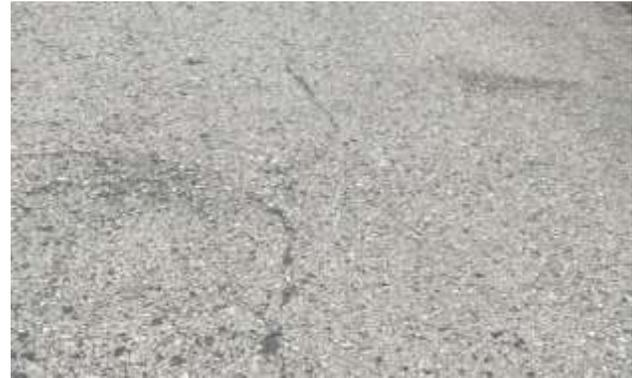
Ilustración 64 : pulimiento de agregados – m 0+360 – 0+400
