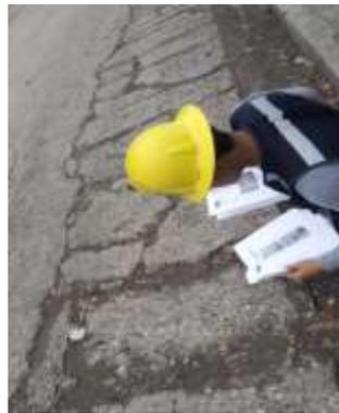
**Nota:** ocurre cuando una losa de pavimento rígido se fractura en dos o más partes debido a cargas excesivas, retracción por cambios de temperatura, o fallas en la base que generan movimientos diferenciales, tomado por Lema & Figueroa, 2025.
