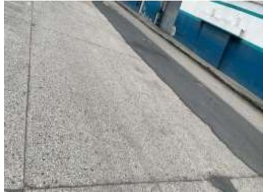
Ilustración 48 : Pulimiento de agregados
