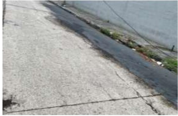
Ilustración 22 : pulimiento de agregados – m 0+030 – 0+040
