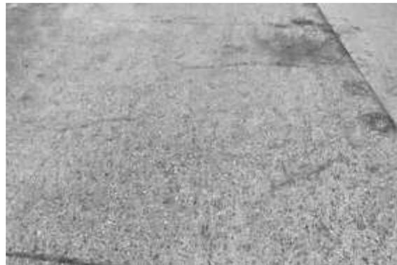
Ilustración 54 : Descascaramiento de junta - m 0+220 – 0+240
