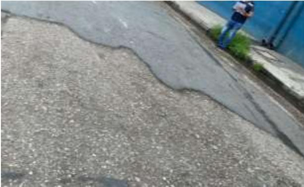
Ilustración 39 : Ilustración 25: pulimiento de agregados – m 0+100 – 0+120
