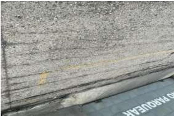
Ilustración 33 : pulimiento de agregados – m 0+060 – 0+080
