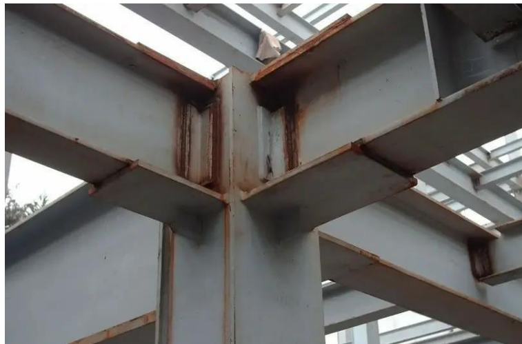
Ilustración 33/ Ejemplo de conexión por soldadura
