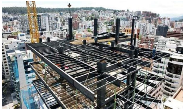
Ilustración 8/Estructura de acero sostenible.
