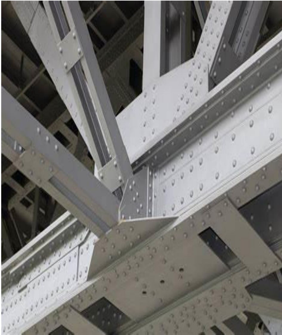
Ilustración 35/Ejemplo de conexiones remachadas
