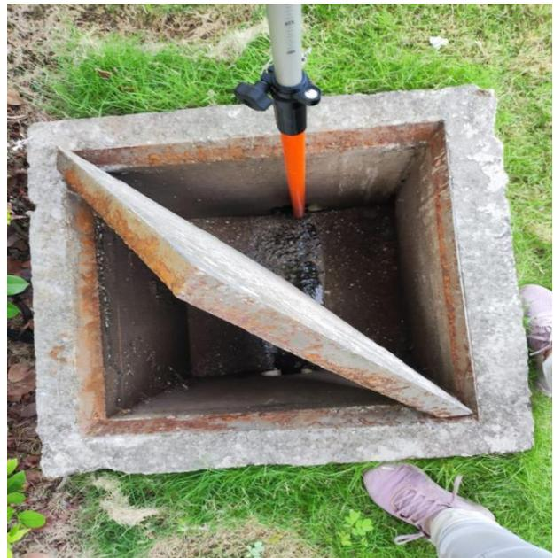
*Ilustración 50: Levantamiento topográfico de cámara de AASS*
