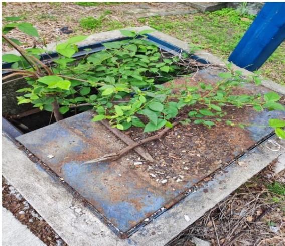
*Ilustración 41: Cárcamo existente fuera de servicio*
