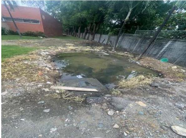
*Ilustración 35: Pozo que recepta las aguas residuales del campus María auxiliadora rebosado*
