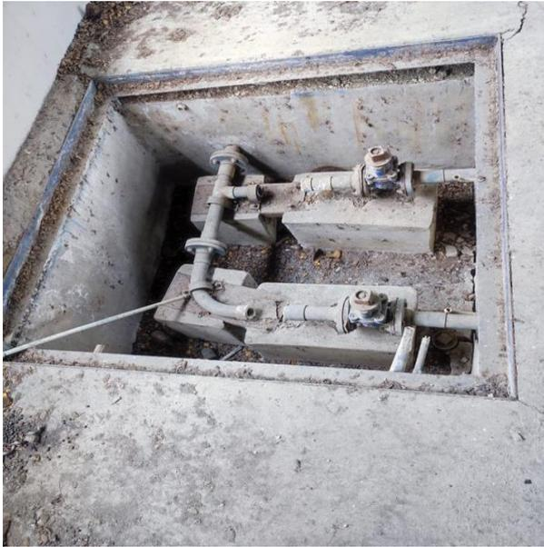
*Ilustración 43: Se evidencia que existieron dos bombas de succión*
