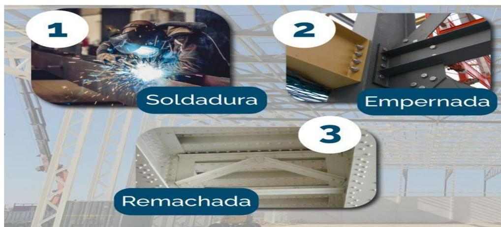
Ilustración 25 Tipos de conexiones de acero. (dgdesignmodeling.com, 2024)
