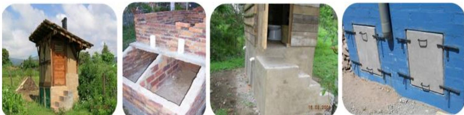
*Ilustración 15. Sistema de compostaje seco de cámara doble.*
