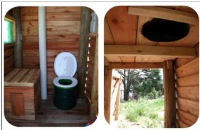
*Ilustración 14. Sistema de compostaje de cámara simple*
