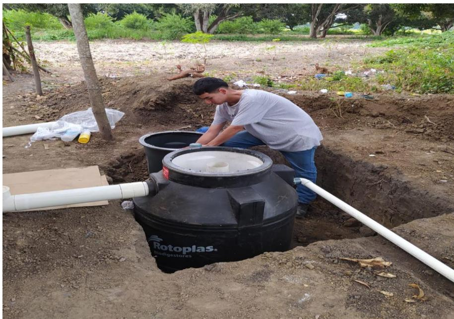
*Fotografía 8. Jeickol Álvarez participando en la instalación del biodigestor.*
