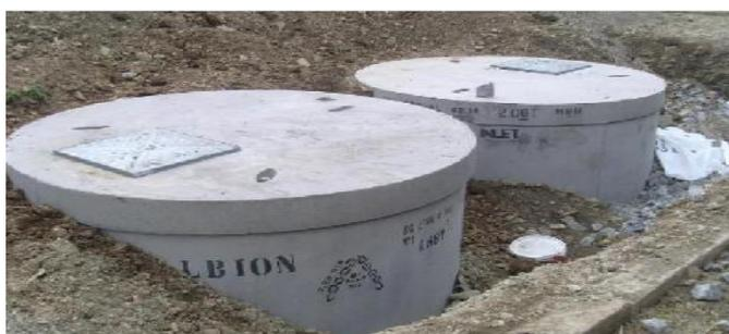
*Ilustración 17. Pozo séptico de concreto*
