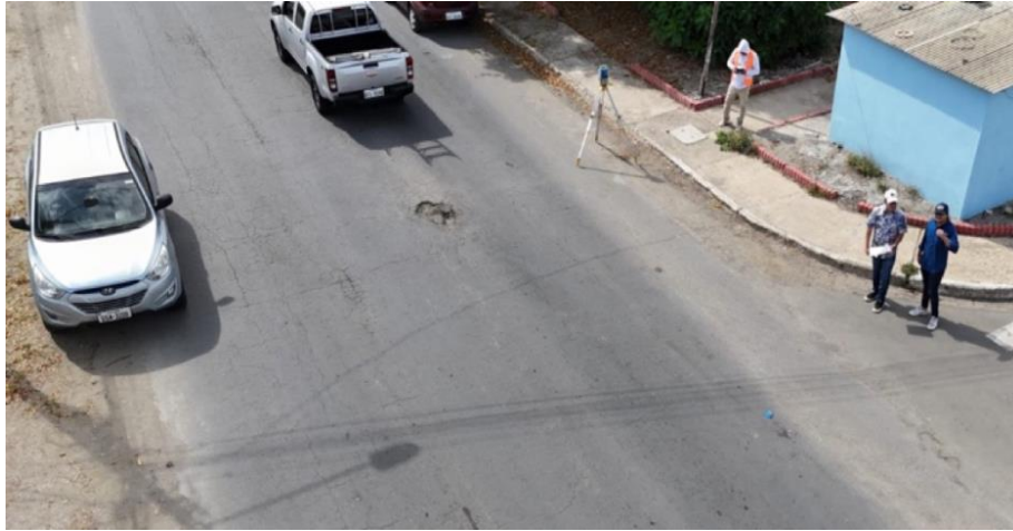
Anexo 9: Vía de pavimento flexible del proyecto.
