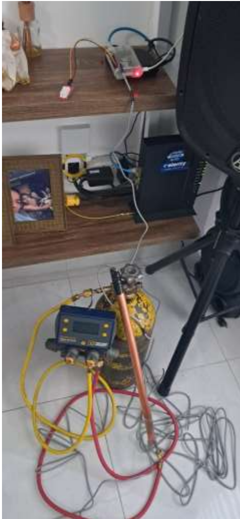
Figura 4 Conexiones de los dispositivos usados en las pruebas
