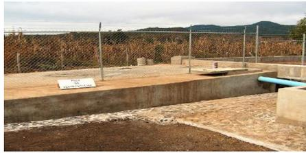
*Nota.* La figura representa el proceso de sedimentación (Tilley, SSWM - SEDIMENTOR, 2018).
