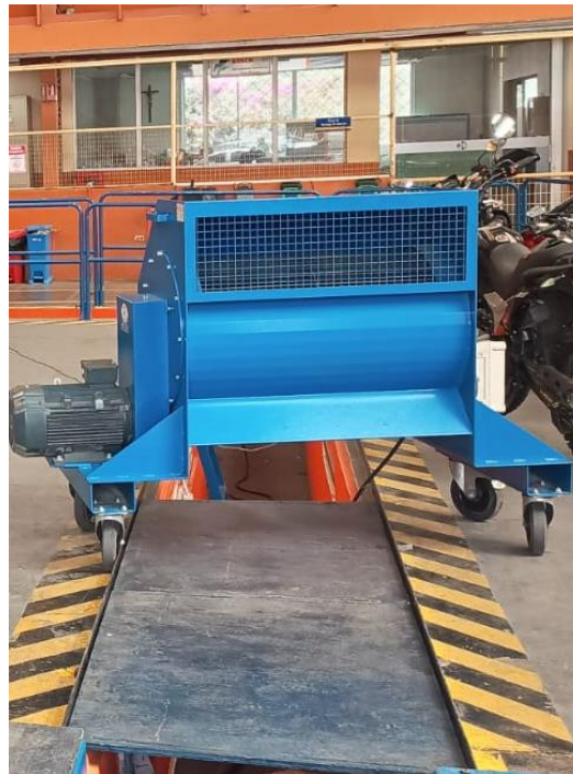
Figura 36. Colocación del ventilador
