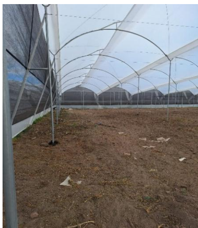
Limpieza del terreno
