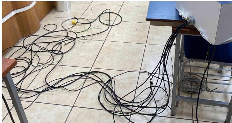
**Figura 2.63:** Conductores sin etiqueta y sin protección
