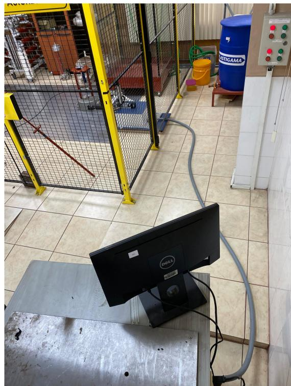
**Figura 2.64:** Tubería Conduit 1" instalada
