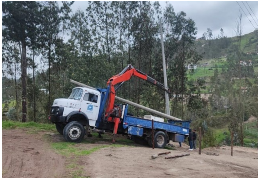
Figura 69: Izado de postes de 12 metros.
