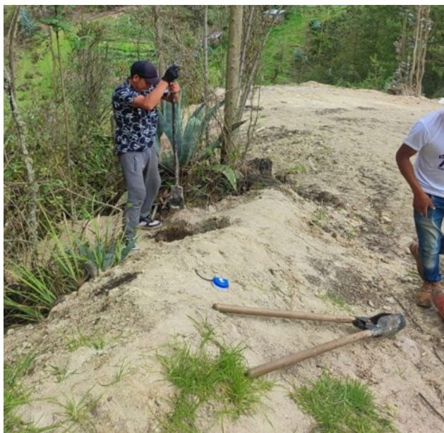
Figura 68: Excavación para la colocación del poste de 12 metros.
